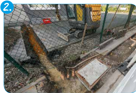
Bauarbeiten sind zielgerichtet und überschaubar.
