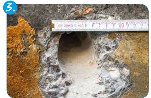
Gerade einmal 50 mm misst das Bohrloch an der Außenwand Ihres Gebäudes, wodurch das Kabelrohr verlegt wird.
