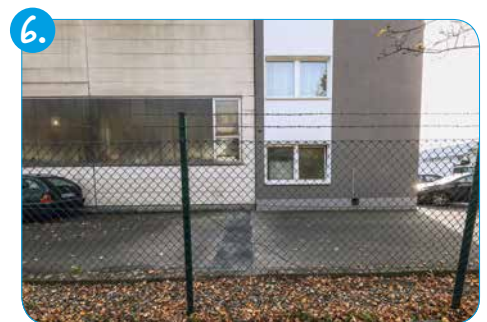
Ihr Gebäude nach den Baumaßnahmen – die Asphaltierung ist sorgfältig erfolgt und alles sieht aus wie zuvor.
