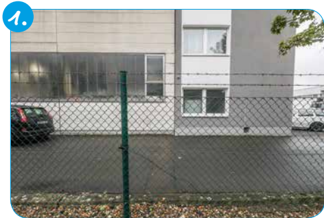
Ihr Gebäude vor den Baumaßnahmen.
